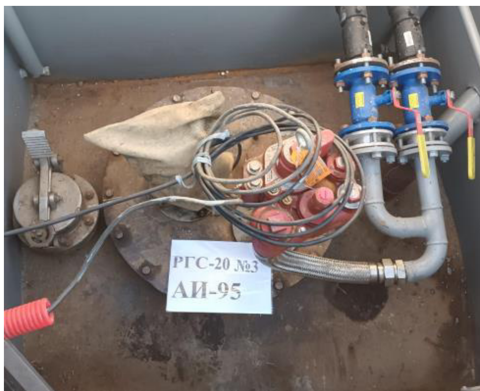
Рисунок 2 – Горловина резервуара РГС-20 зав.№ 3
