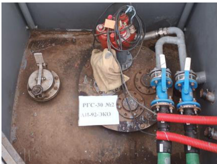
Рисунок 3 – Горловина резервуара РГС-30 зав.№ 2
