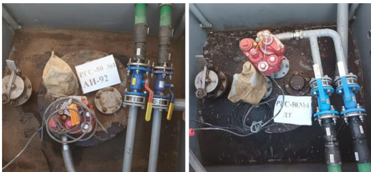
Рисунок 4 – Горловины резервуаров РГС-50 зав.№№ 1, 4
