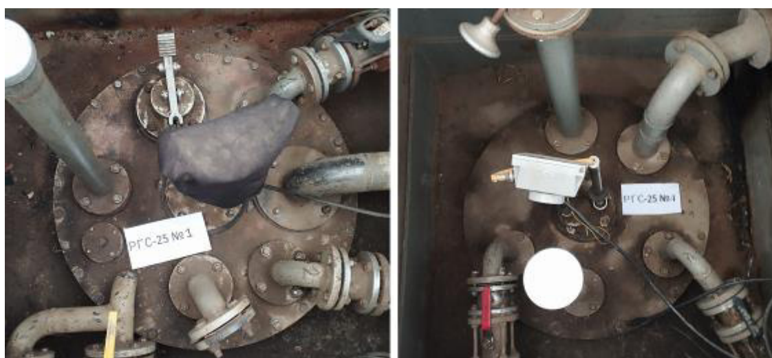
Рисунок 4 – Горловины резервуаров РГС-25 зав.№№ 1, 4
