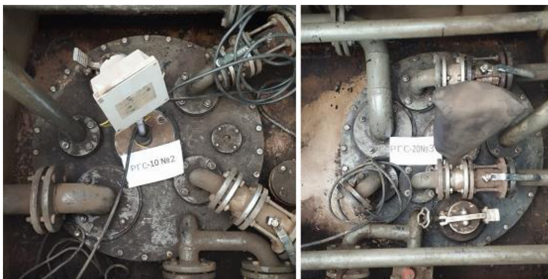
Рисунок 3 – Горловины резервуаров РГС-10 зав.№ 2, РГС-20 зав.№ 3
