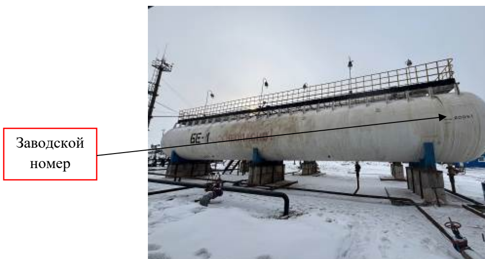
Рисунок 1 – Общий вид резервуара горизонтального стального цилиндрического РГС-180, заводской номер 20061 с указанием места нанесения заводского номера
