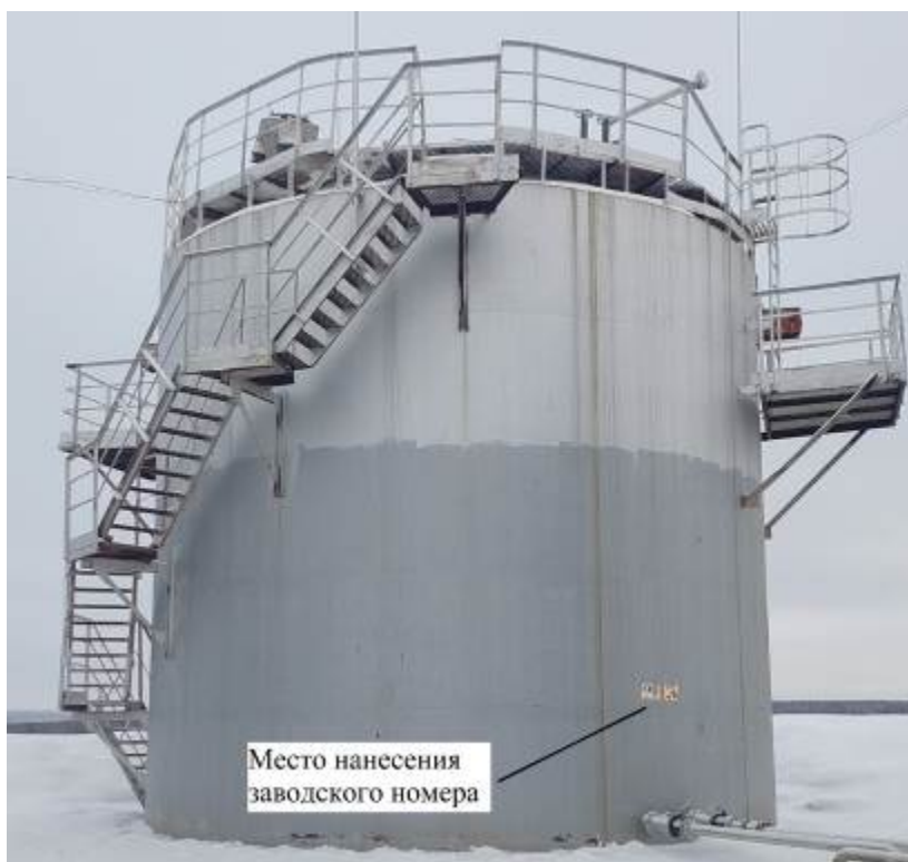
Рисунок 2 – Общий вид резервуара вертикального стального цилиндрического РВС, РВС-400 зав.№ 2.13 с указанием места нанесения заводских номеров
