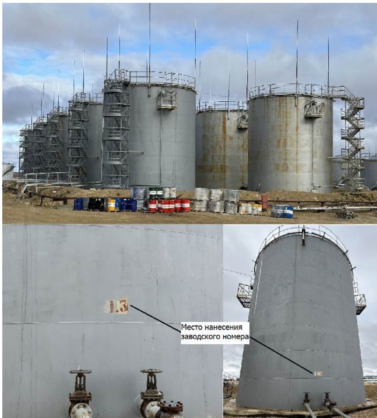
Рисунок 1 – Общий вид резервуаров вертикальных стальных цилиндрических РВС, РВС-1000 зав.№№ 1.1, 1.2, 1.3, 1.4, 1.5, 1.6, 1.7, 1.8, 1.9, 1.10 с указанием места нанесения заводских номеров
