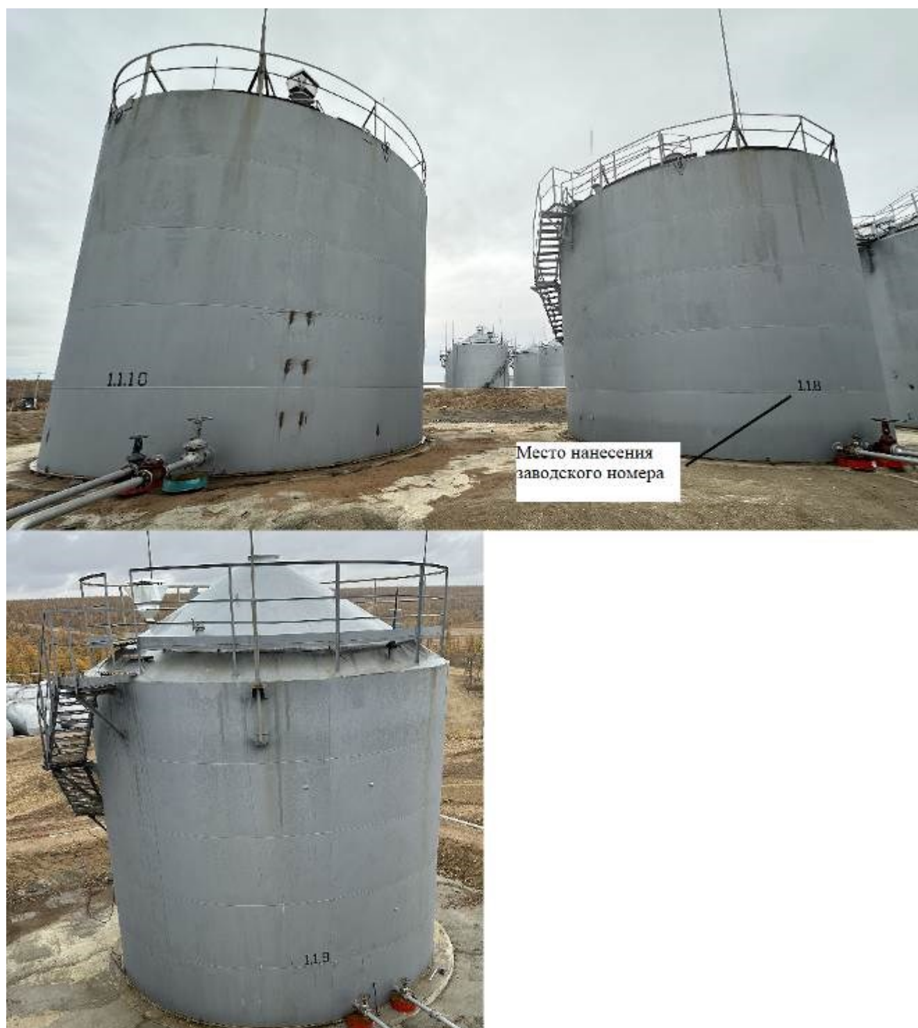
Рисунок 2 – Общий вид резервуаров вертикальных стальных цилиндрических РВС-400, зав.№№ 1.1.8, 1.1.9, 1.1.10 с указанием места нанесения заводских номеров
