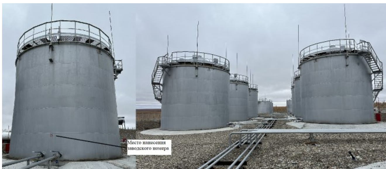
Рисунок 2 – Общий вид резервуара вертикального стального цилиндрического РВС, РВС-400 зав.№№ 5, 6, 7, 8, 9, 10 с указанием места нанесения заводских номеров
