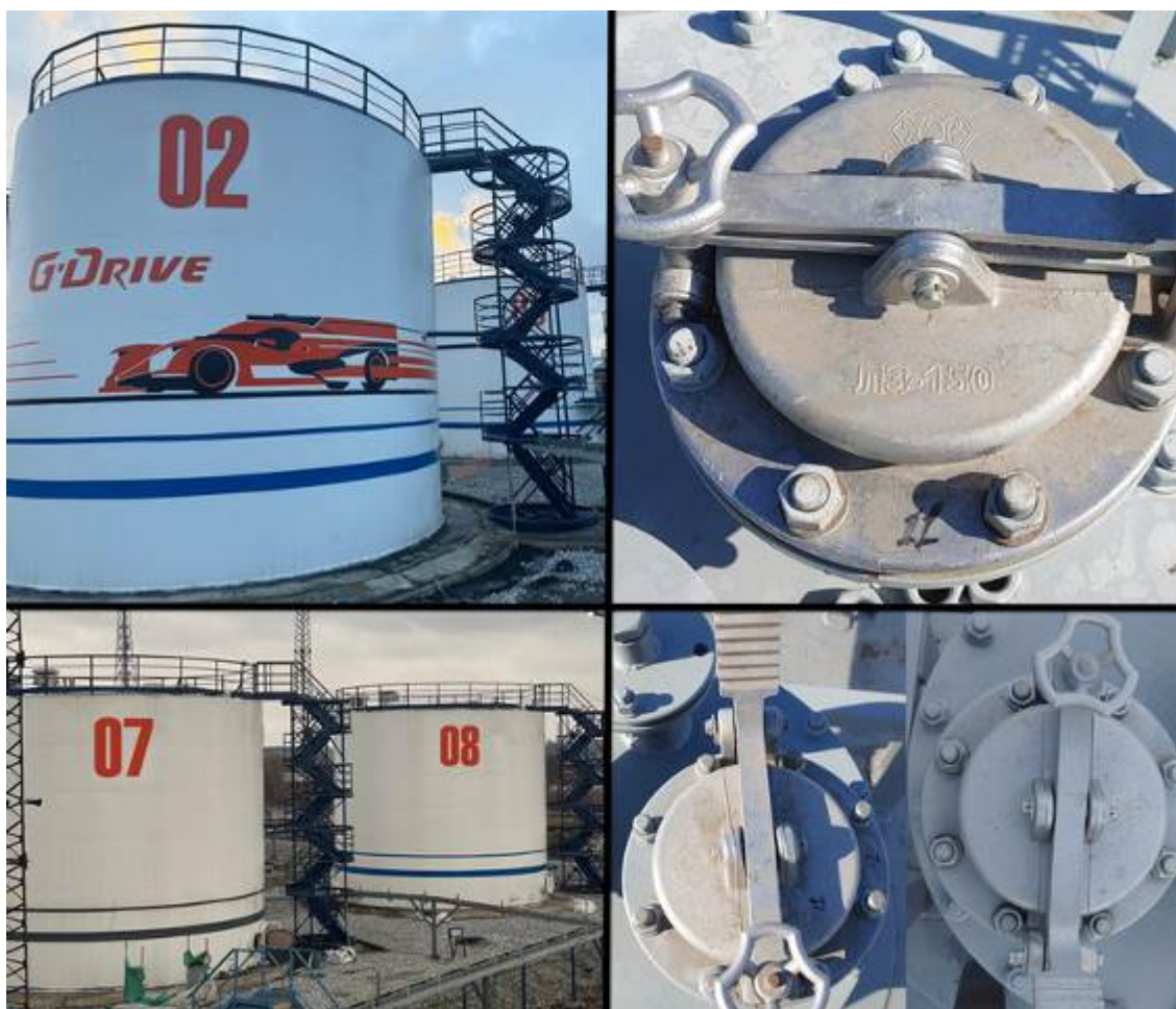
Рисунок 1 – Фотографии общего вида резервуаров стальных вертикальных цилиндрических РВСП-400(№№ 07, 08), РВСП-2000(№ 02), горловин замерных люков и заводских номеров
