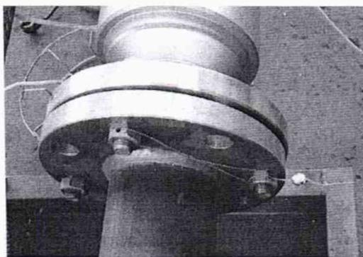
Рисунок 1 - Пломба поверителя, препятствующая демонтажу СРМ
