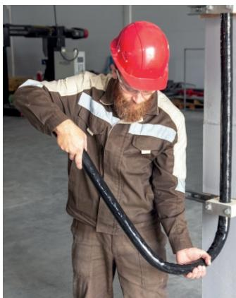
Метод 2. Крепко возьмите пучок и поверните его на 90°, затем сделайте изгиб. Этот метод также можно использовать для позиционирования трубы для технологического соединения.
